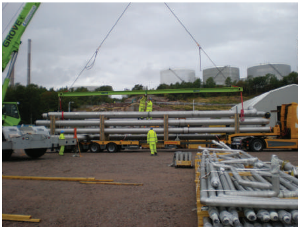
Figure 1. On site at the Lysekil LNG terminal.
